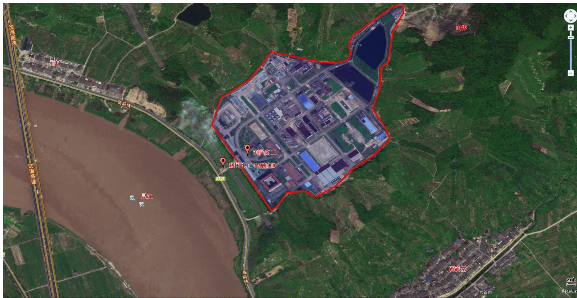
2.3-2 临海市利民化工有限公司周边环境概况
